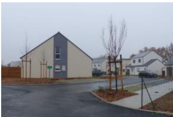
ZAC Moinerie - Réception tranche 1
